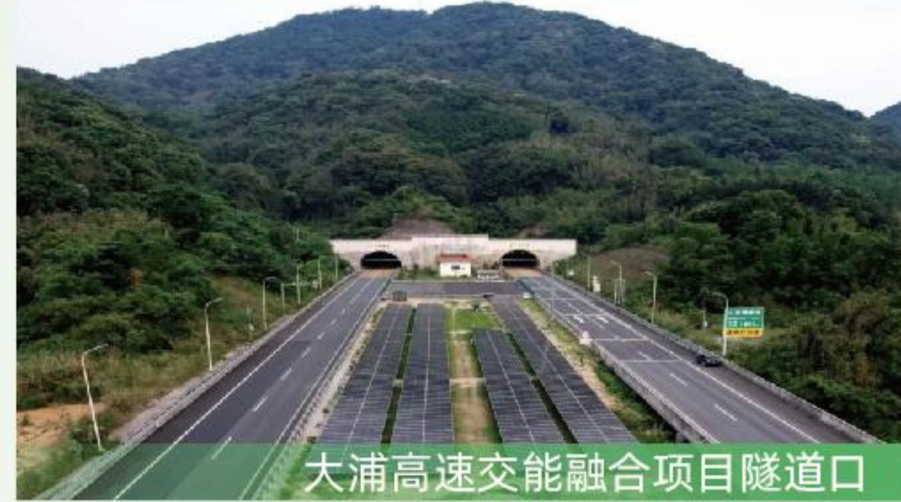
大浦高速交能融合项目隧道口
