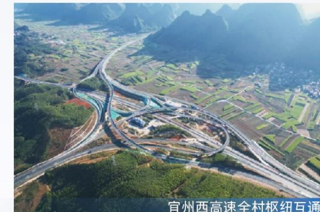
宜州西高速全村枢纽互通
