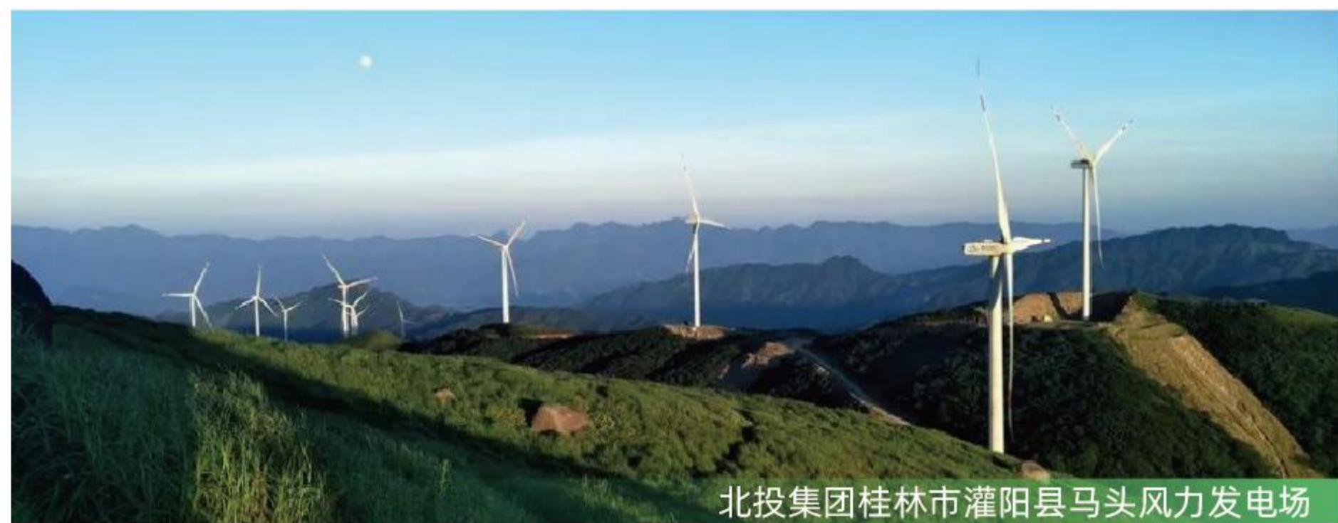
北投集团桂林市灌阳县马头风力发电场
