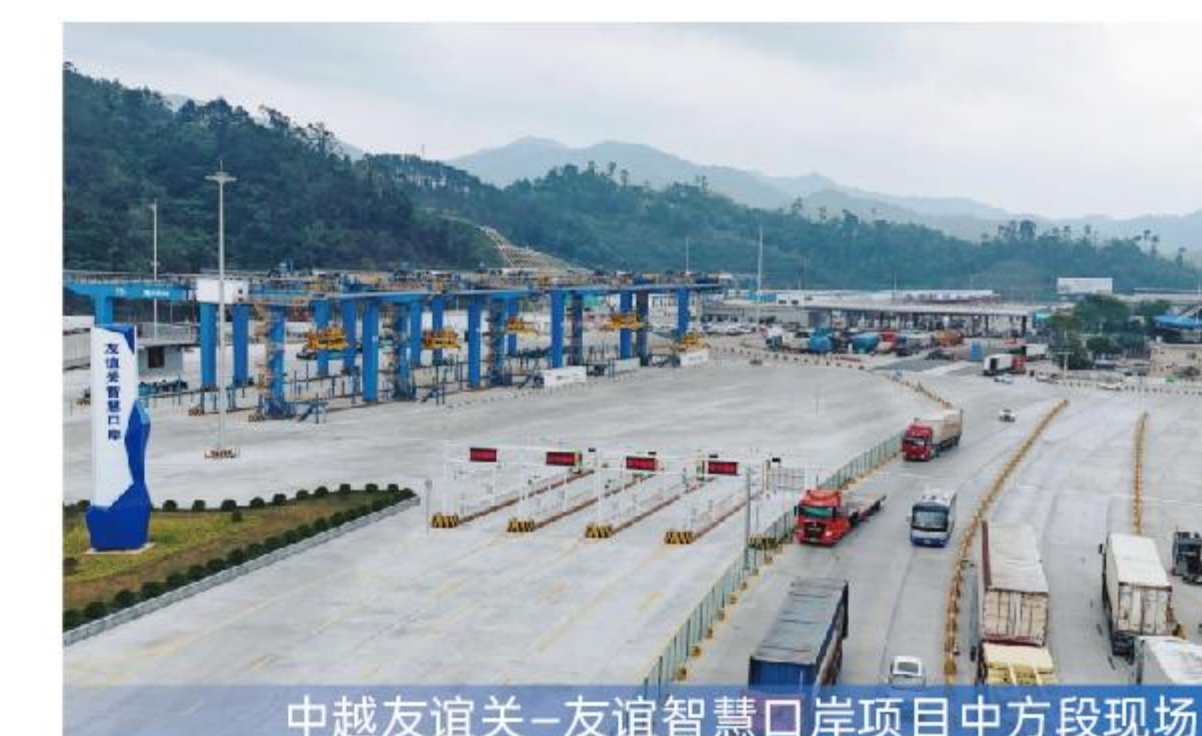
中越友谊关-友谊智慧口岸项目中方段现场
