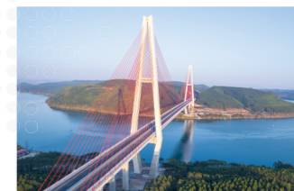
▲武忻高速武宣黔江特大桥
