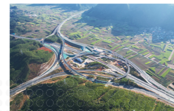
▲宜州西高速全村枢纽互通
