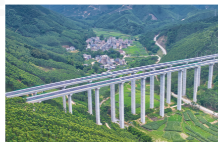
▲南湛高速簕竹头大桥
