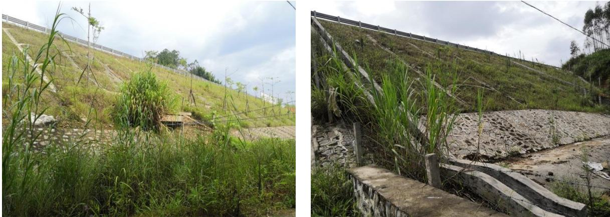
图 5.3-8 路基防护工程
