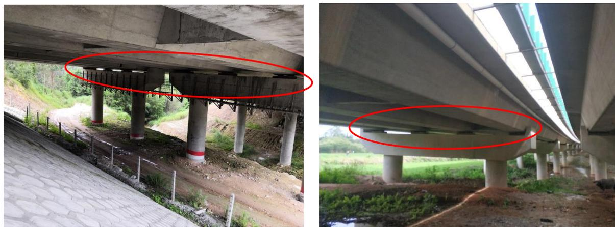
图 6.5-1 桥梁段减振垫示例
