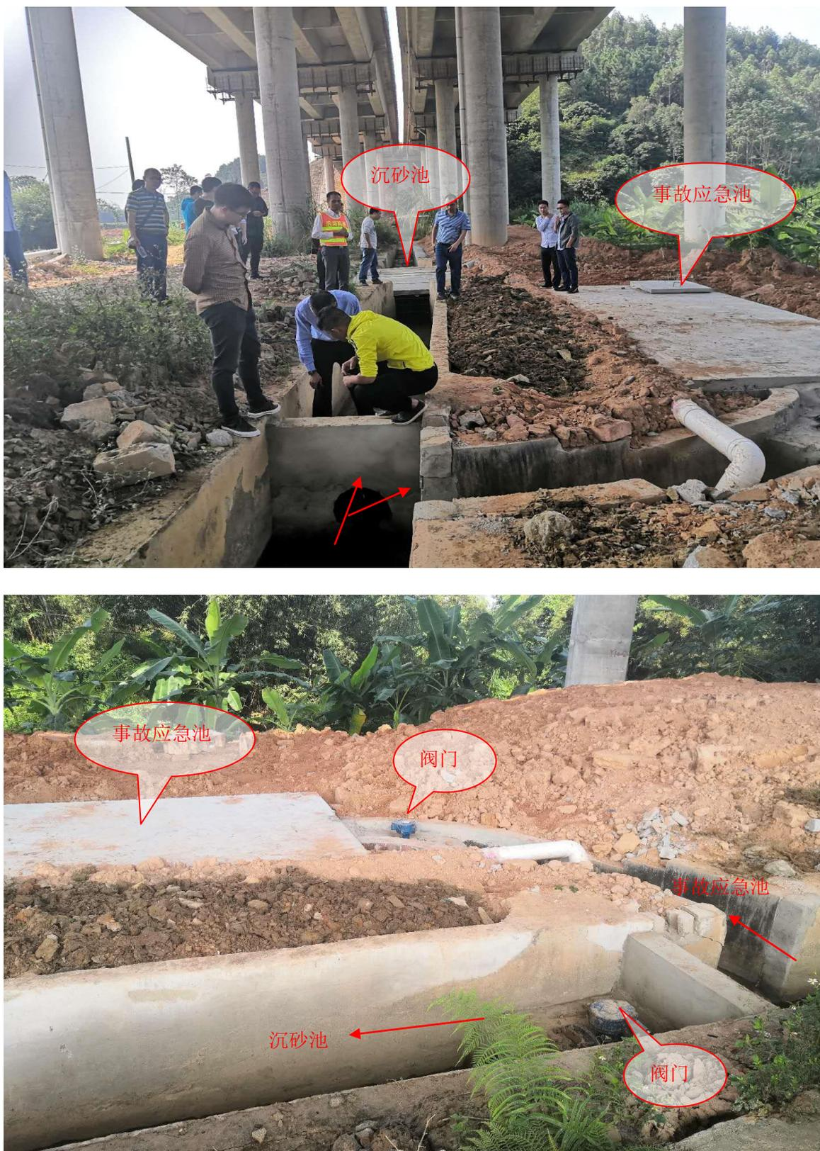
图 3.2-2 穿越饮用水源保护区小江大桥桥梁应急措施
